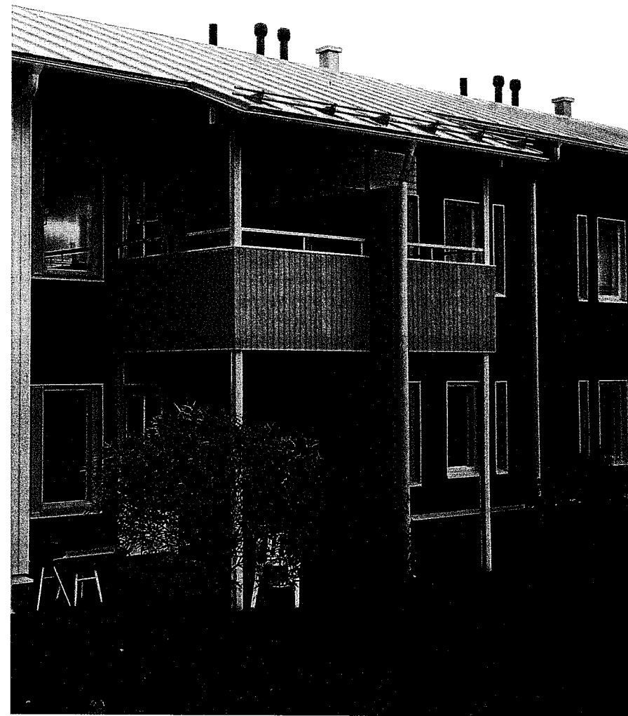
Oulun Sivakka Oy, Keluveneenväylä 1, Oulu. Arkkitehtuuritoimisto Seppo Valjus Oy. Kuva Centrum Studiot
