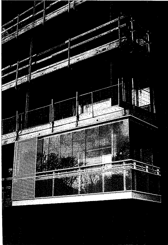
Vuonna 2004 Skanska teki Etelä-Suomessa yli 500 parveketta Parman vakioalattalla. Lumonin kaidetta käytettiin yli 6 km. Kuva Matti Matikainen
