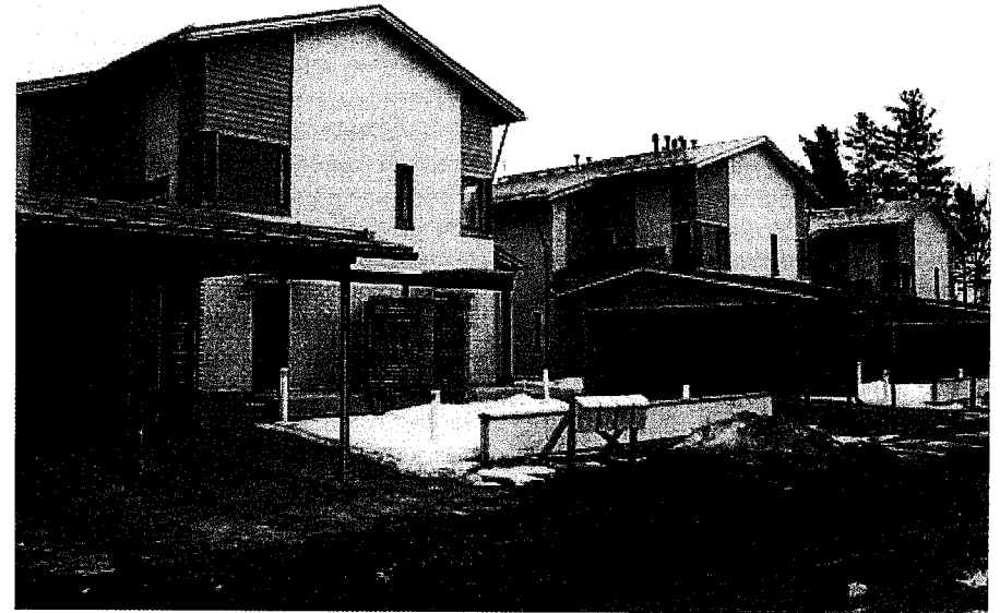
Matalaa ja tiivistä rakentamista Oulusta, jossa katutilan julkisuutta ei ole erityisesti korostettu. Kuva Lauri Tuokko
