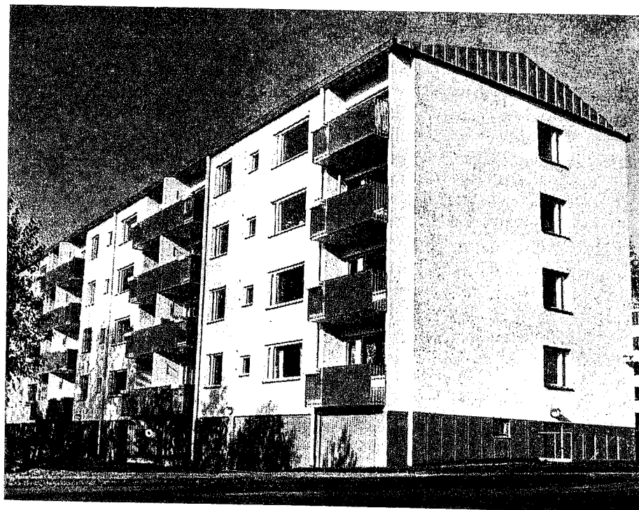
Nybygget Storkärrsvägen 8 i Månsas. Färdigt 1963.
